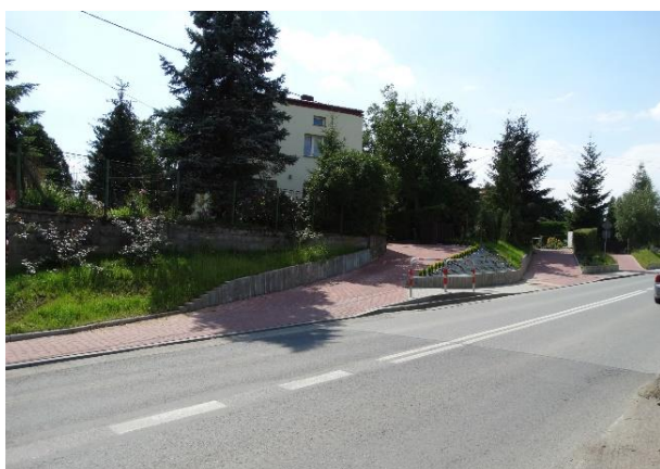
Zdjęcie 17. Chodnik przy drodze 794, Źródło: UG Zielonki
