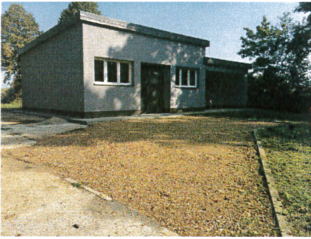
nowo uruchamiane ujęcie Batowice – obiekt przed otwarciem
